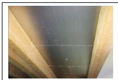
Obr.č.1 Interiérový pohled
